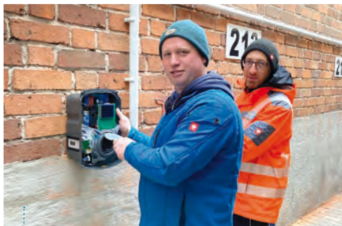
Elektriker Robert Westphal installiert mit Thomas Becker die Wallboxen im Parkhaus »Am Meeresmuseum«.
