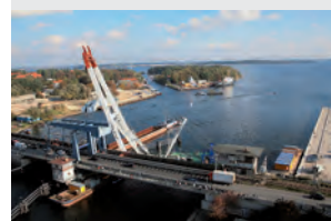
Reparatur der alten Ziegelgrabenbrücke
