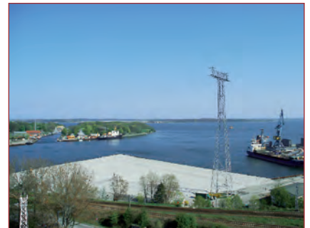
7 Nach zwei Jahren Bauzeit konnte nun der neue Südhafen in Betrieb genommen werden.
