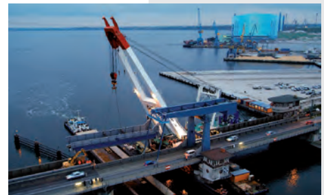
Südhafen und alte Ziegelgrabenbrücke
